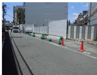
工事中のマルエツ前の道路
