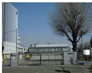
高津小学校（新年度トイレ工事、校舎増築の設計）
