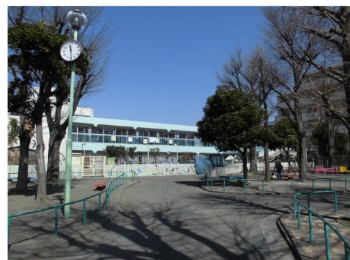
西高津保育園（隣の溝口北児童公園から撮る）
