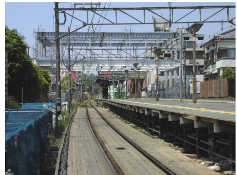
津田山駅橋上に組まれた桁
