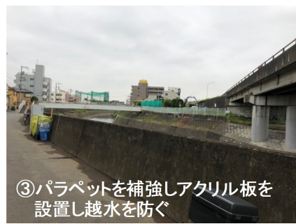
②大型土のうを設置（左岸）
